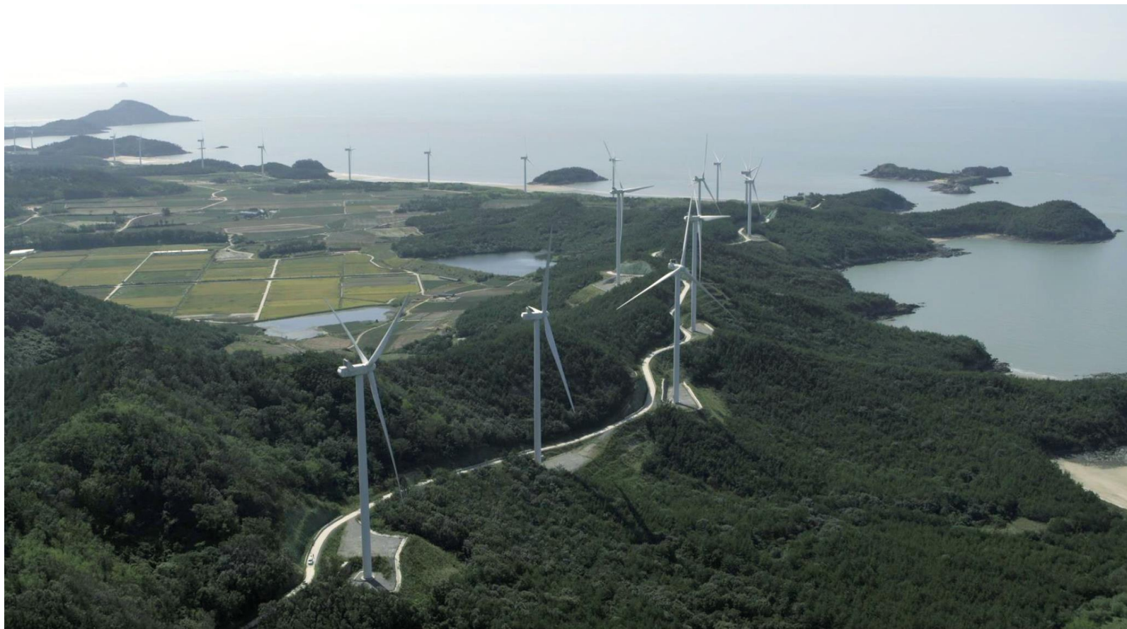
26. 전남 100MW 육상 풍력발전단지 조성 Project [발전] Capacity:풍력발전-63MW 기간 : 2016.02~2018.12
