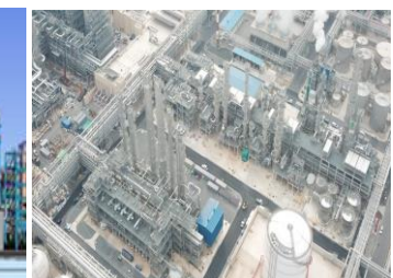
LG화학 여수BRU Project
