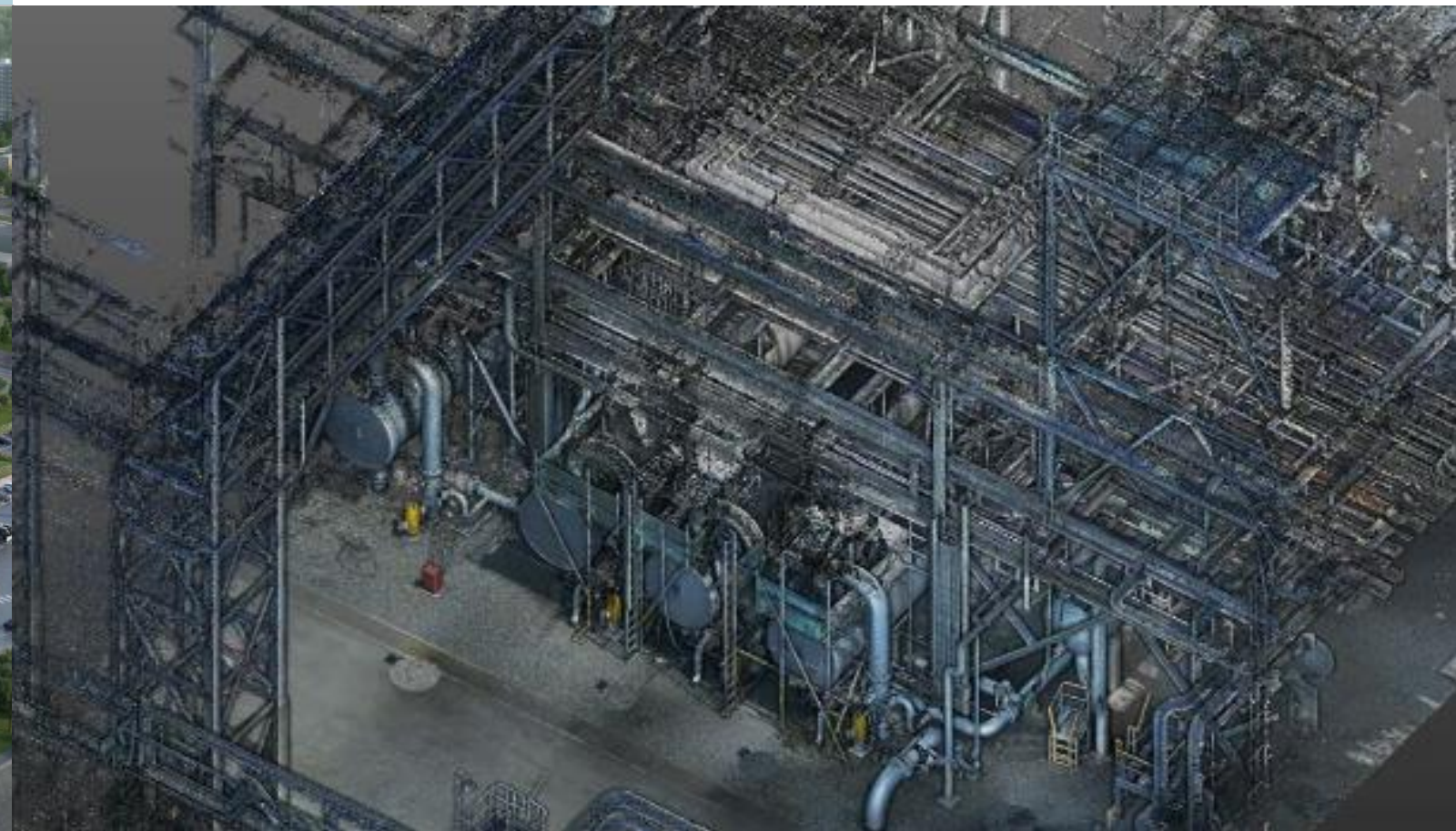
25. LG화학 여수 NCC T/A Project [석유화학_NCC(Naphtha Cracking Center)] 기간 : 2022.05~2023.08
