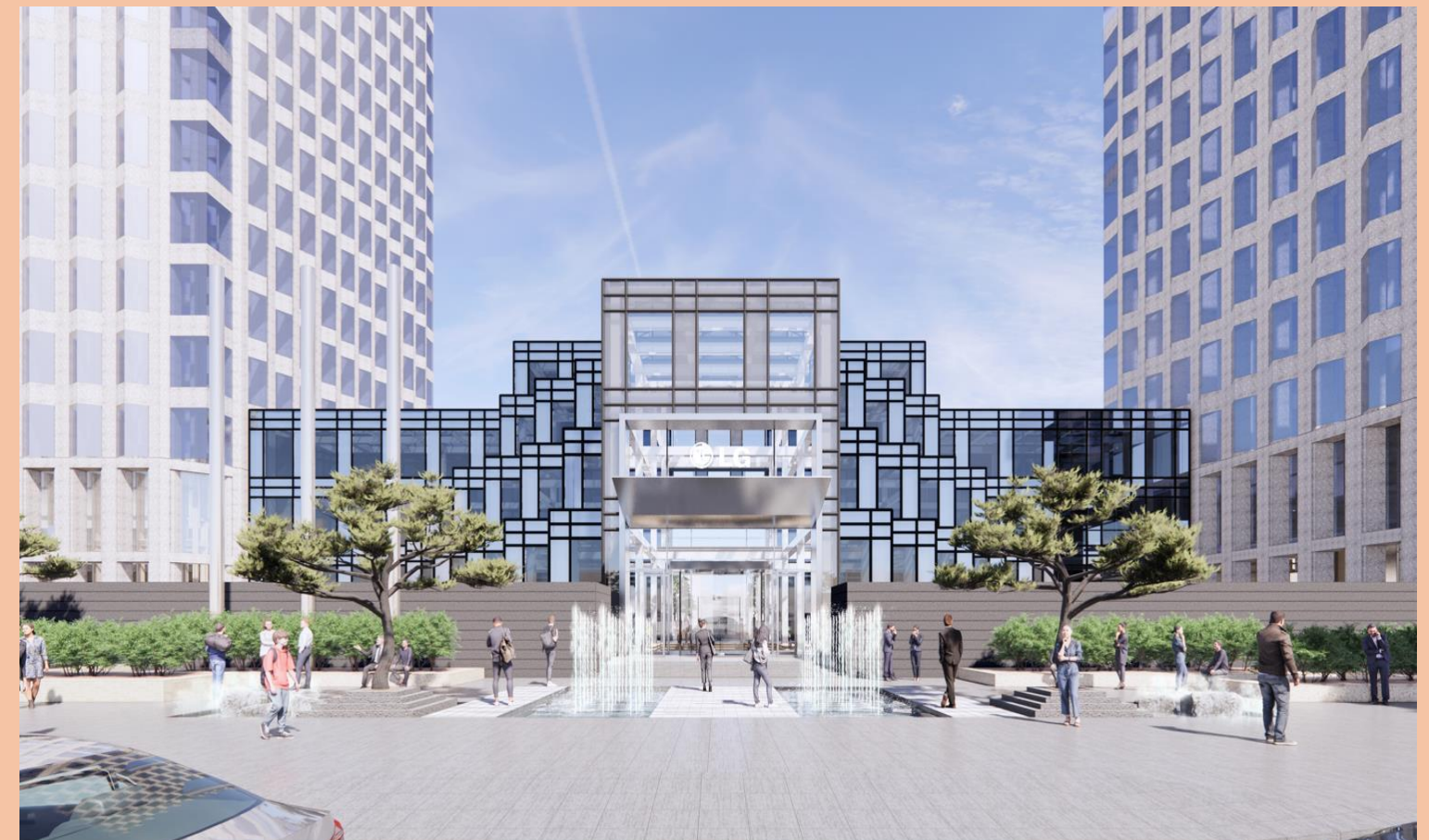
23. 여의도 트윈타워 리뉴얼 공사 업무/연구시설 2021.11.01~진행중
