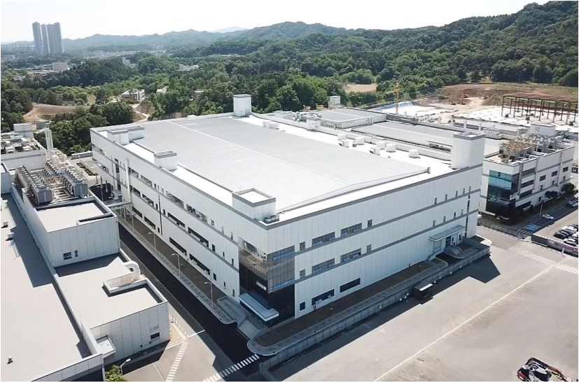
09. LG에너지솔루션 오창2공장 시험연구동 [전지 시설] 연면적 : 56,700㎡ 기간 : 2021.06~2022.05
