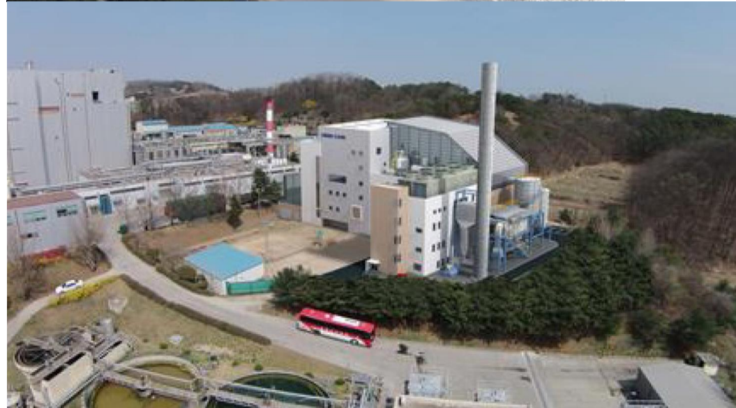
27. 남양유업 에너지합리화사업 Project [발전] Capacity:증기터빈-5MW 기간 : 2015.01~2016.12
