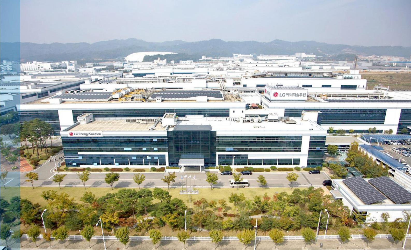
11. LG에너지솔루션 오창1공장 [전지 시설] 연면적 : 243,800㎡ / 기간 : 2010.07~2017.07
