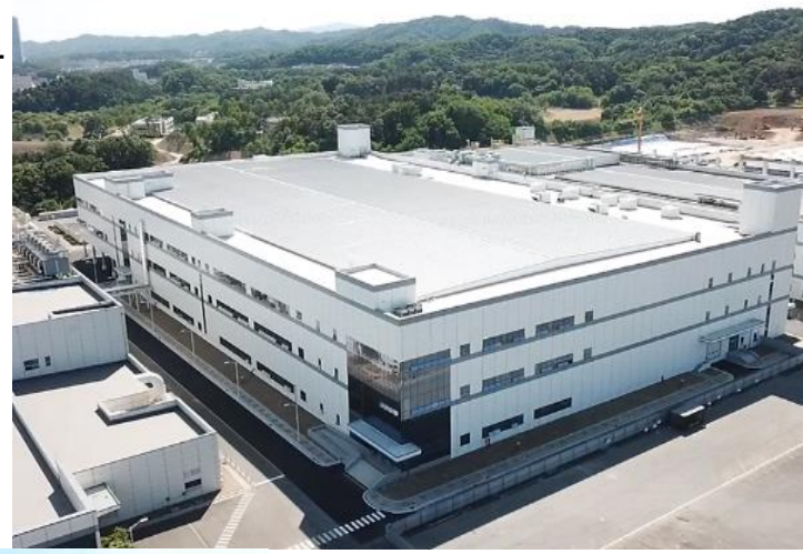
20. LGES 오창 2공장 시험연구동 업무/연구시설 2021.05.31 ~ 2023.08.31
