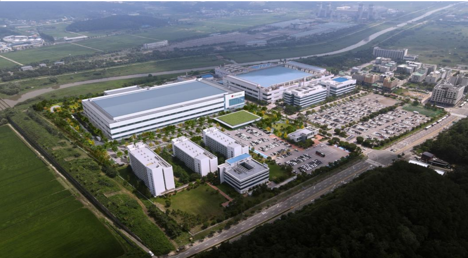
34. LG이노텍 파주2공장 신축공사(1공장 Capa-up) [첨단생산시설] 기간 : 2022.10~2023.03
