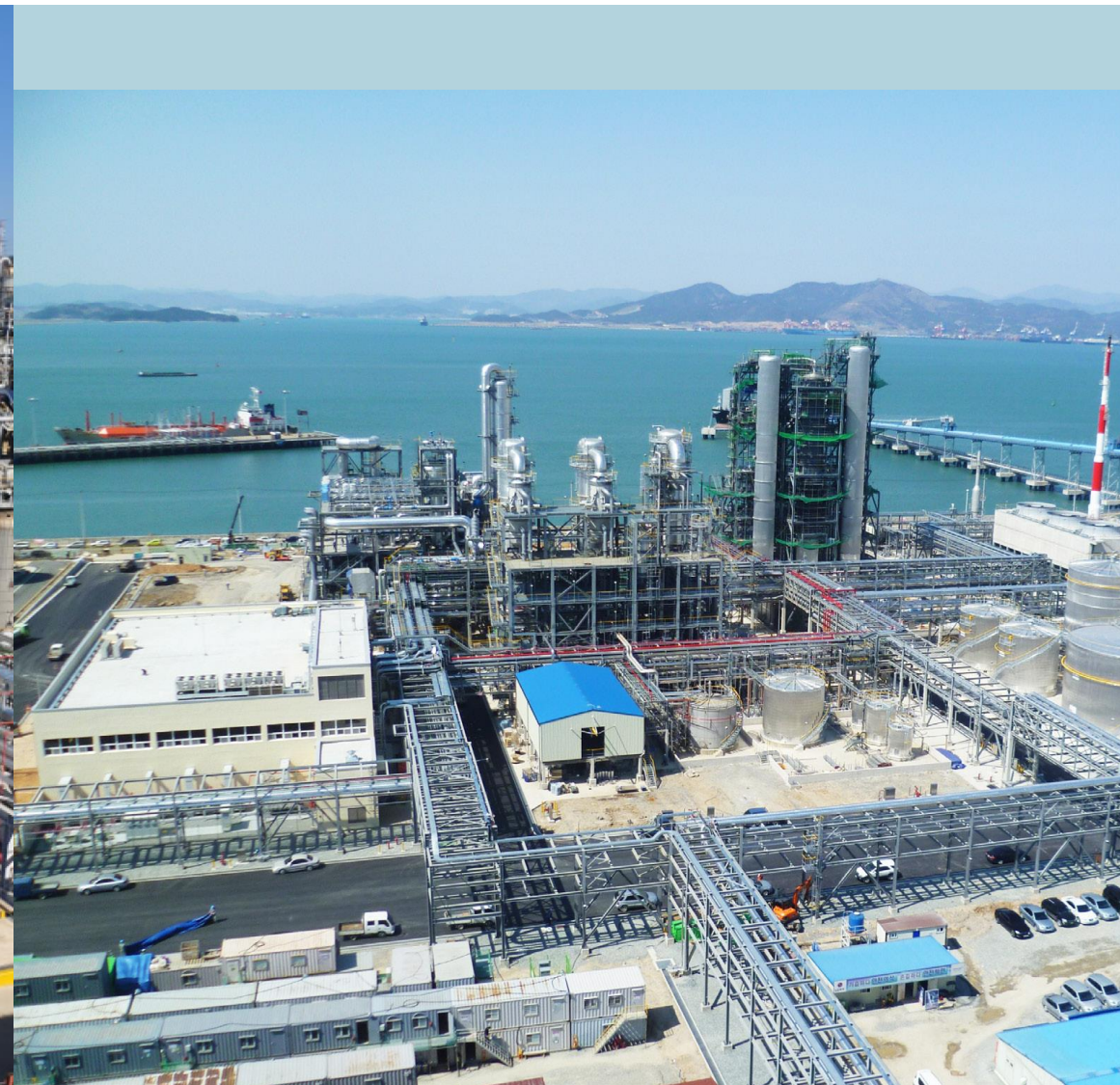
12. LG화학 여수 5AA Project [석유화학_아크릴/SAP] Capacity:CAA (Crude Acrylic Acid) -16만톤/년 기간 : 2014.05~2015.12
