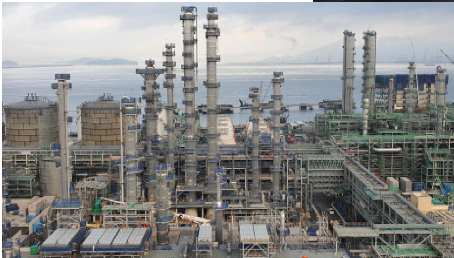
03. LG화학 여수 BRU Project [석유화학_NCC] Capacity:Benzene-35만톤/년 기간 : 2019.6~2021.08
