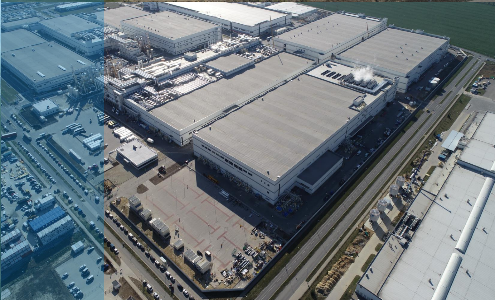
32. LG에너지솔루션 폴란드 자동차 전지공장 전국2동 및 조립3동 신축공사 [전지시설] 기간 : 2018.04~2021.06
