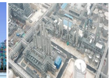
LG화학 여수BRU Project
