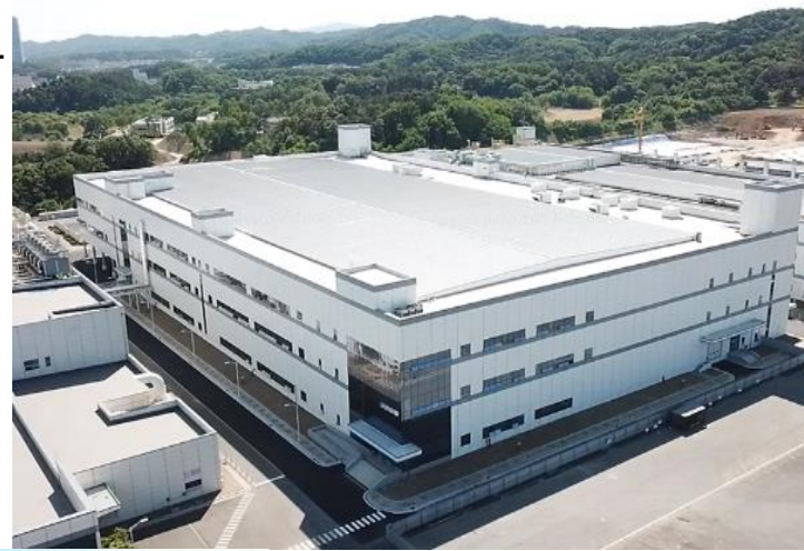
20. LGES 오창 2공장 시험연구동 업무/연구시설 2021.05.31 ~ 2023.08.31
