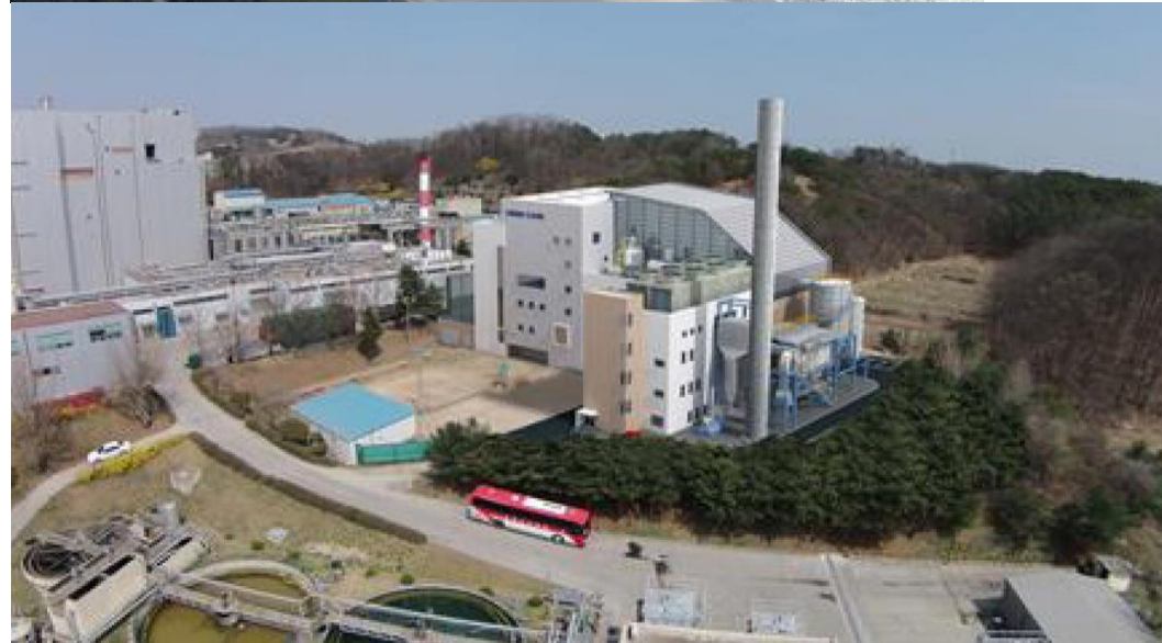
27. 남양유업 에너지합리화사업 Project [발전] Capacity:증기터빈-5MW 기간 : 2015.01~2016.12
