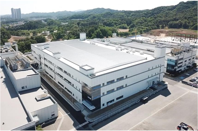
09. LG에너지솔루션 오창2공장 시험연구동 [전지 시설] 연면적 : 56,700㎡ 기간 : 2021.06~2022.05
