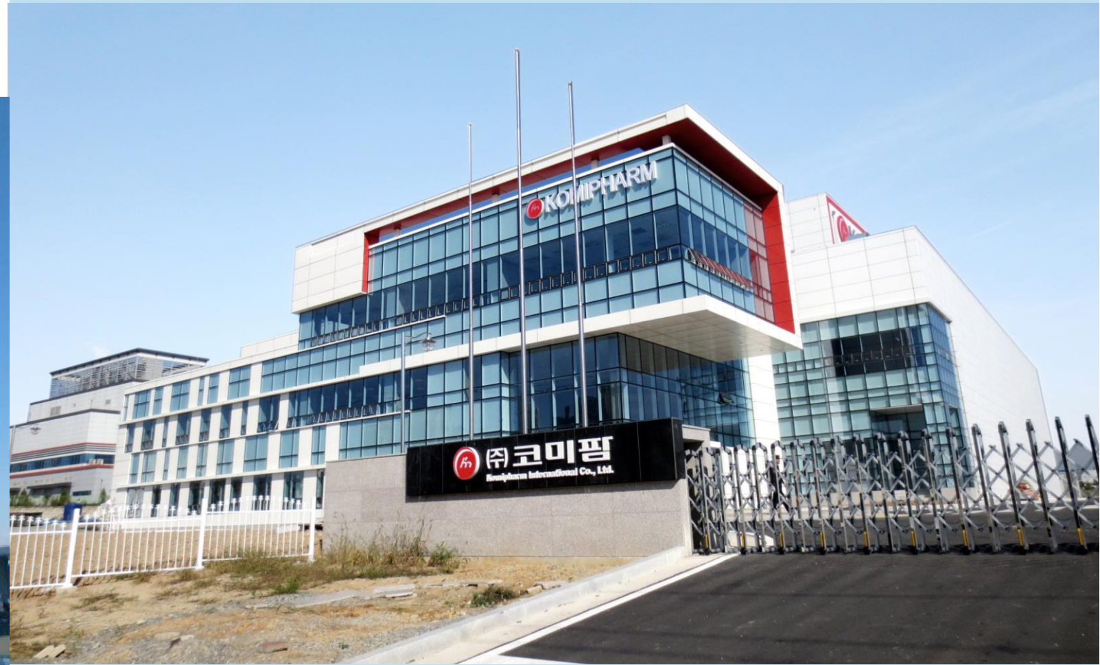
20. 코미팜 오송 항암제공장 [GMP 시설] 연면적 : 9,411㎡ 기간 : 2012.07~2013.11
