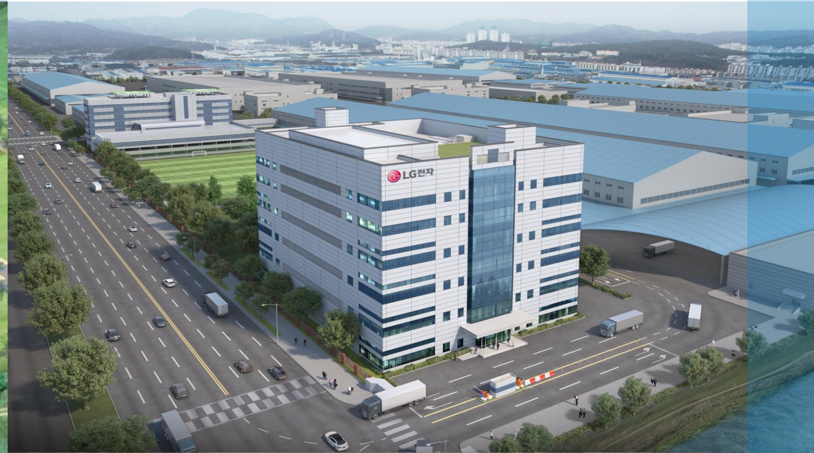
27. LG전자 창원 2공장 리빙어플라이 언스 통합 시험동 [첨단 생산시설] 기간 : 2021.02~2022.09
