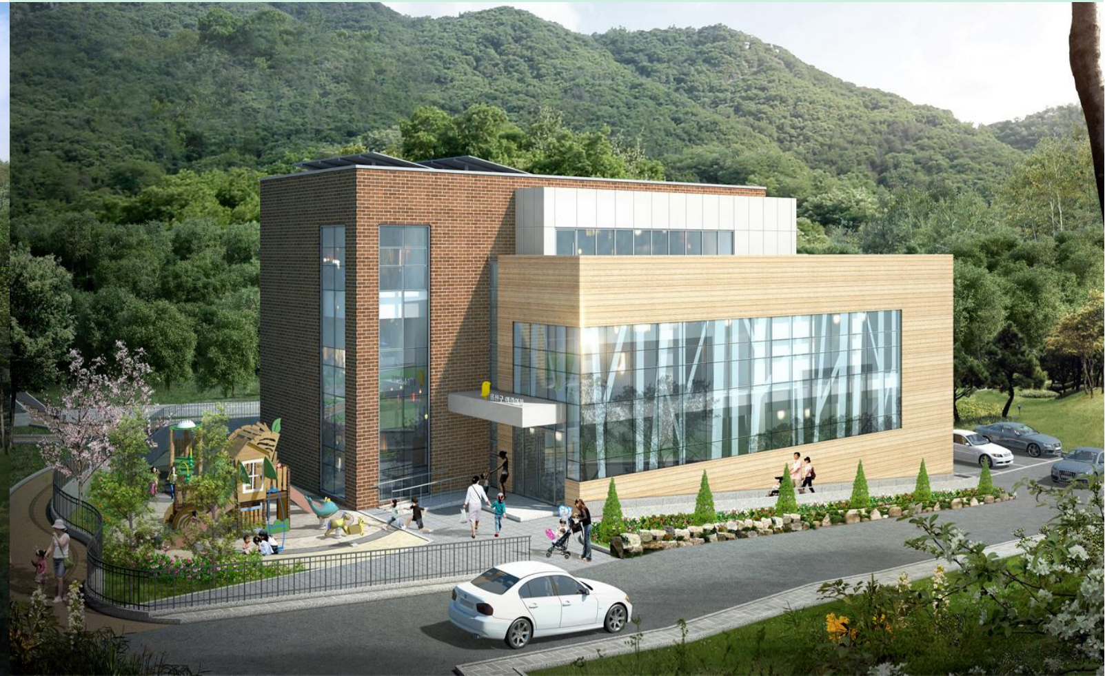
12. LG복지재단 한남동 어린이집 신축공사 [복지시설] 기간 : 2017.07~2018.03
