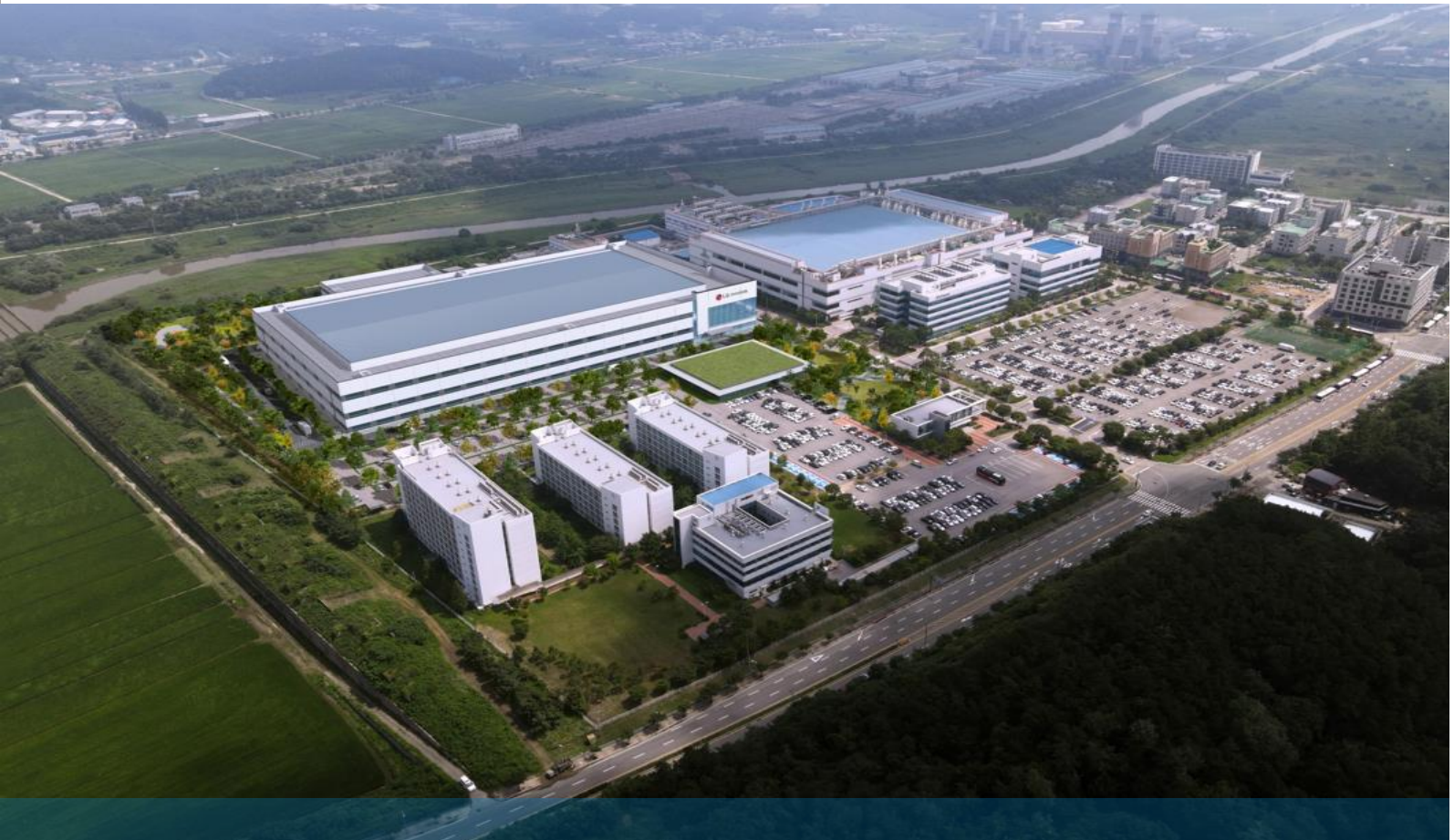
34. LG이노텍 파주2공장 신축공사(1공장 Capa-up) [첨단생산시설] 기간 : 2022.10~2023.03
